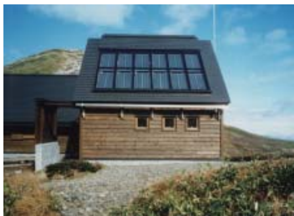
屋根面 太陽光発電パネル設置
